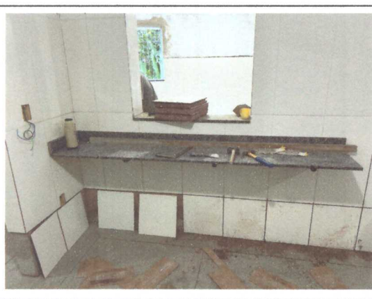
Assentamento de bancada da cozinha
