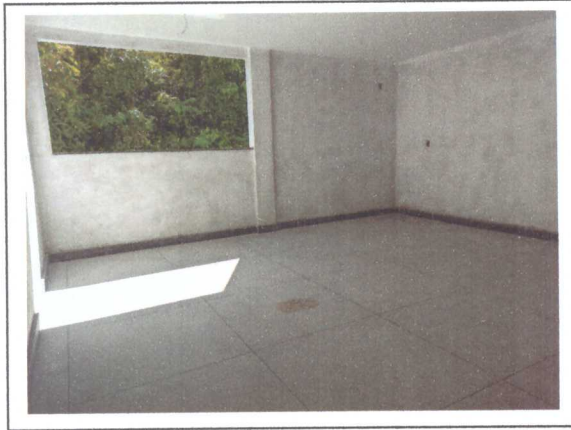
Assentamento de rodapé de granito
