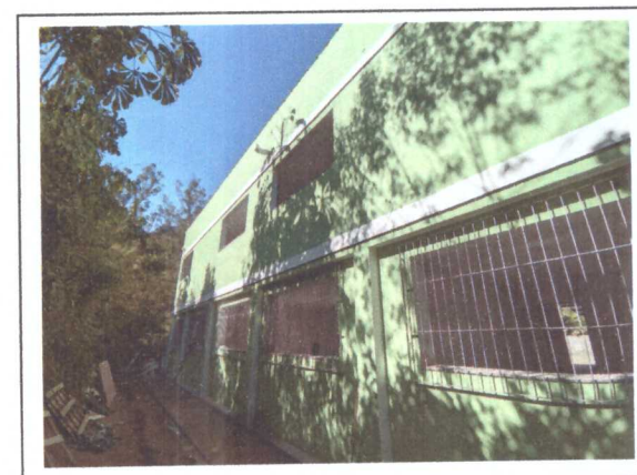
Instalação das grades de proteção
