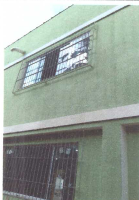
Instalação das janelas
