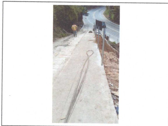
Execução da rampa para acesso a escola
