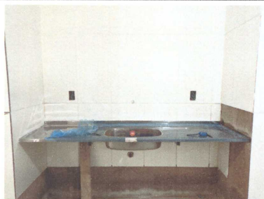
Assentamento da pia da cozinha
