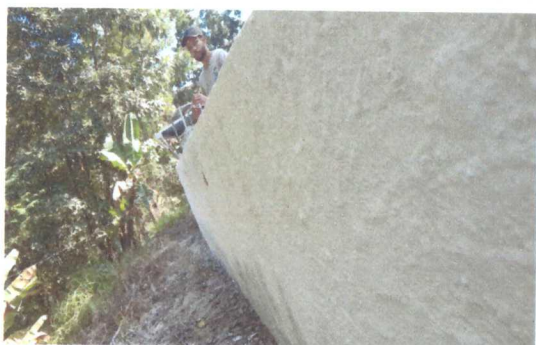
Pintura do muro
