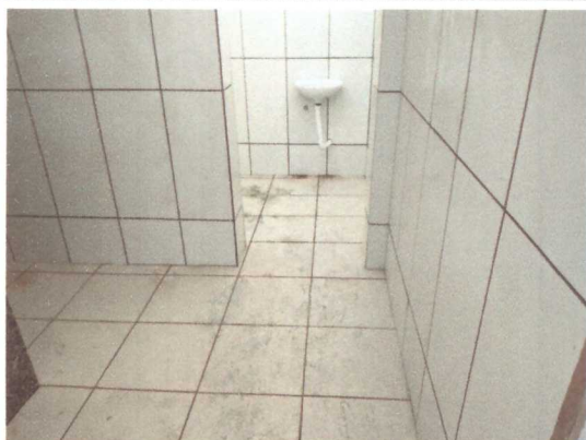
Assentamento de pia dos banheiros
