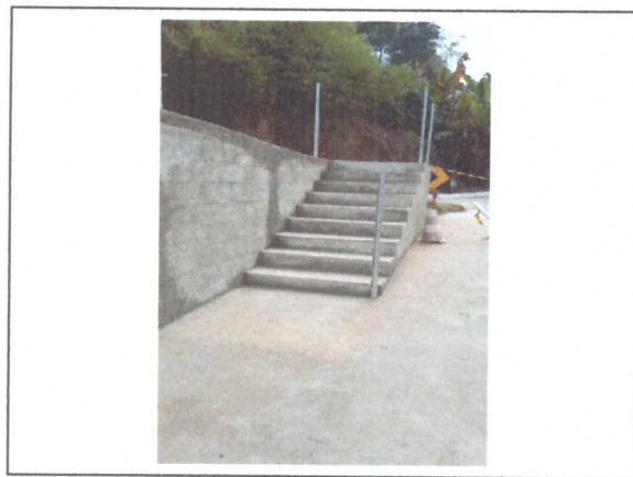
Execução de escada para acesso a escola
