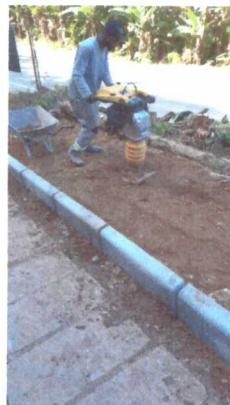
Execução da rampa de acesso a escola
