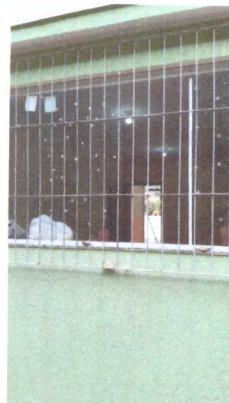
Instalação das janelas
