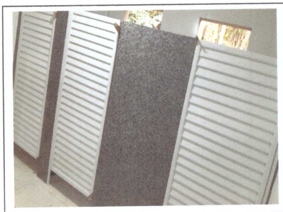
Instalação das portas dos banheiros
