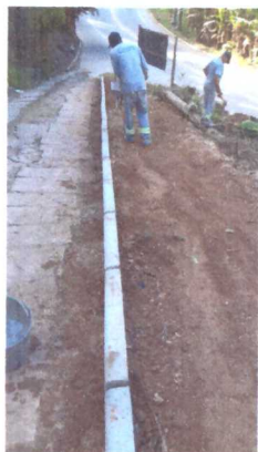
Execução da rampa de acesso a escola
