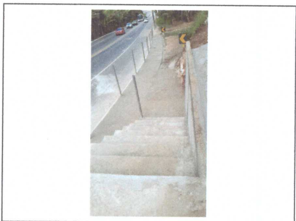
Execução de escada para acesso a escola
