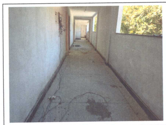
Assentamento de rodapé de granito
