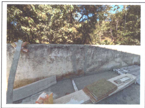
Reparo do muro
