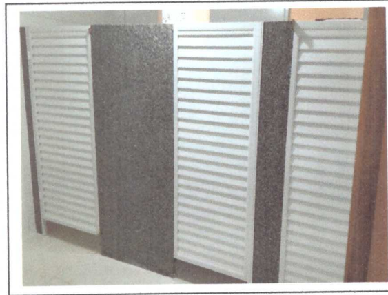
Instalação das portas dos banheiros
