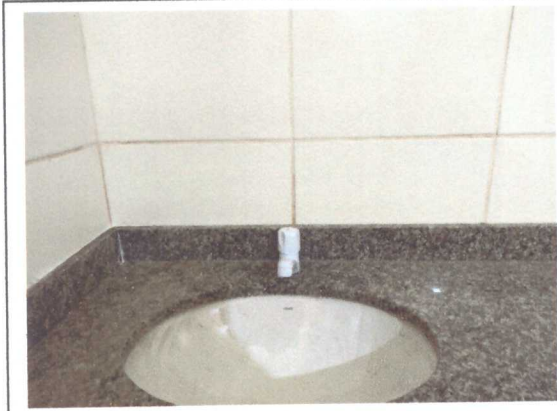
Assentamento de pia dos banheiros
