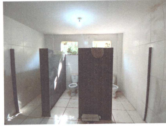
Assentamento de divisória de granito
