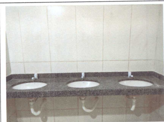
Assentamento de pia dos banheiros
