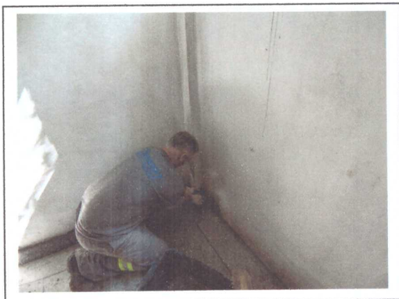
Assentamento de rodapé de granito
