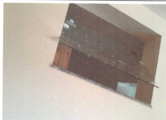
Instalação das janelas
