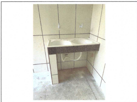
Tanque da área de serviço
