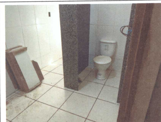
Assentamento de divisória de granito
