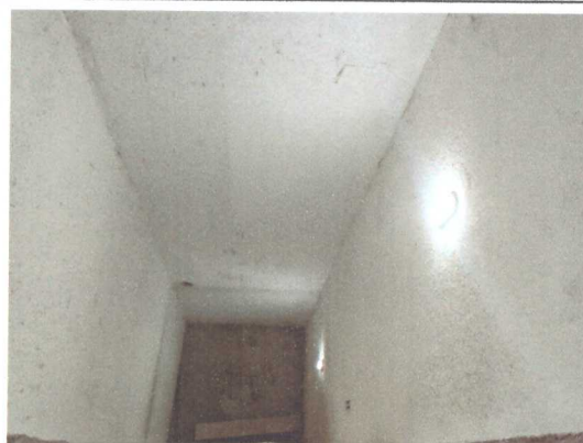
Poço do elevador
