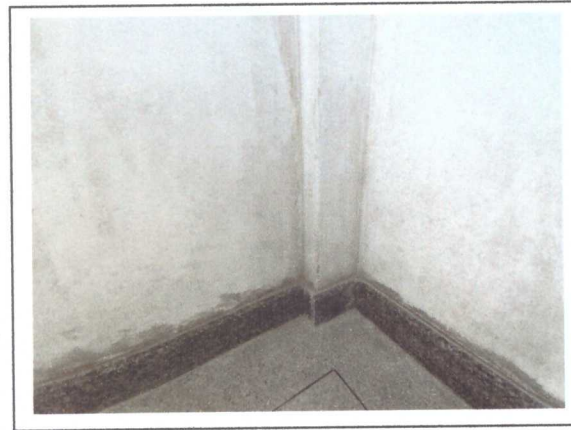
Assentamento de rodapé de granito
