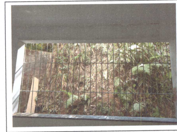
Instalação das grades de proteção
