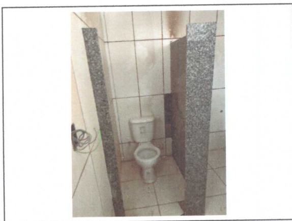
Assentamento de divisória de granito
