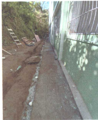
Reparo de calçada
