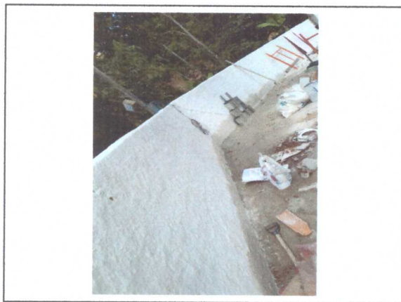
Pintura do muro
