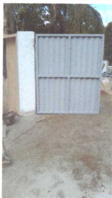
Instalação do portão
