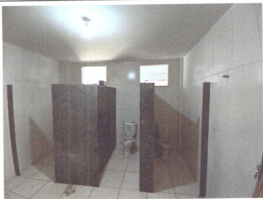
Assentamento de divisória de granito
