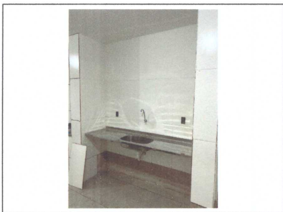
Assentamento de pia da cozinha
